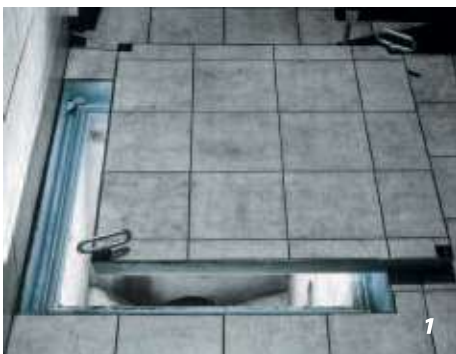
1 Typ BV-GD zamontowana w supermarkecie
